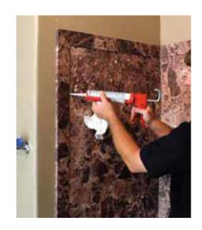
PLEASE WAIT 24 HOURS BEFORE INSTALLING FINISH PLUMBING OR USING YOUR NEW TUB/SHOWER SURROUND. REMOVE REMAINING PROTECTIVE MASKING PRIOR TO USE.
